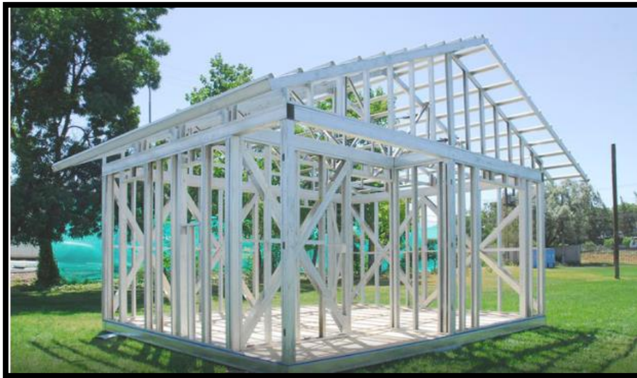
Ilustración 13: Estructura de una casa realizada en el estilo Steel Framing.
